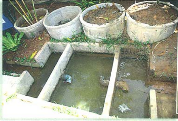
บ่อดักตะกอน
